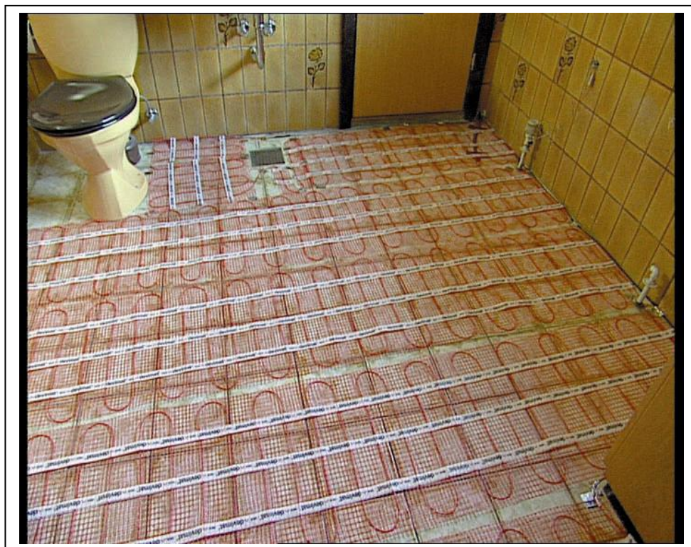
Рис. 3. Монтаж нагревательного мата Devimat™ DSVF в ванной комнате.
